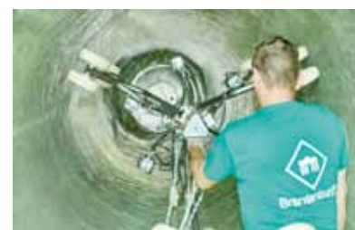
Aushärtung des Liners
